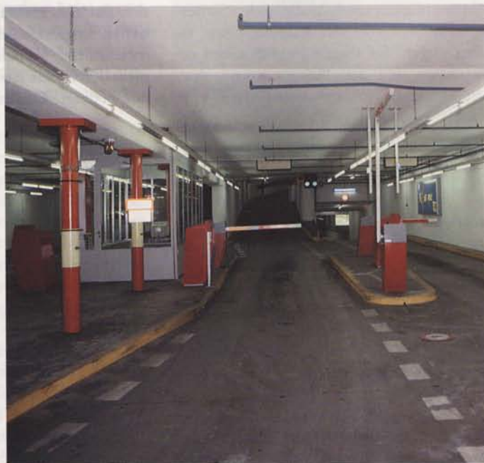
Einfahrt Parkhaus «Hohe Promenade», Zürich: an den Säulen links im Bild gelbe nachleuchtende Bänder mit Pfeilen zum Ausgang (Bild: B.Hersche)
