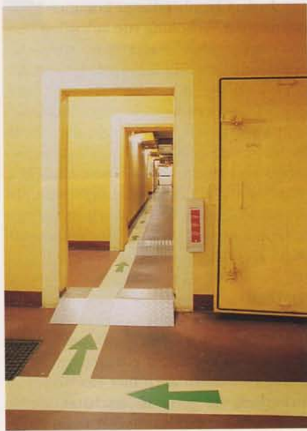
Fluchwegmarkierung und Äusgänge markiert mit nachleuchtender Farbe (Bild: Longlite Technologies AG)
